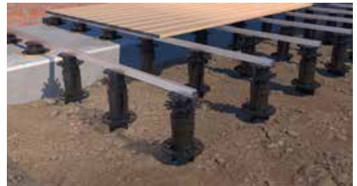
Erweiterung eines Terrassenfundaments mit dem Erdanker FLEXI.
